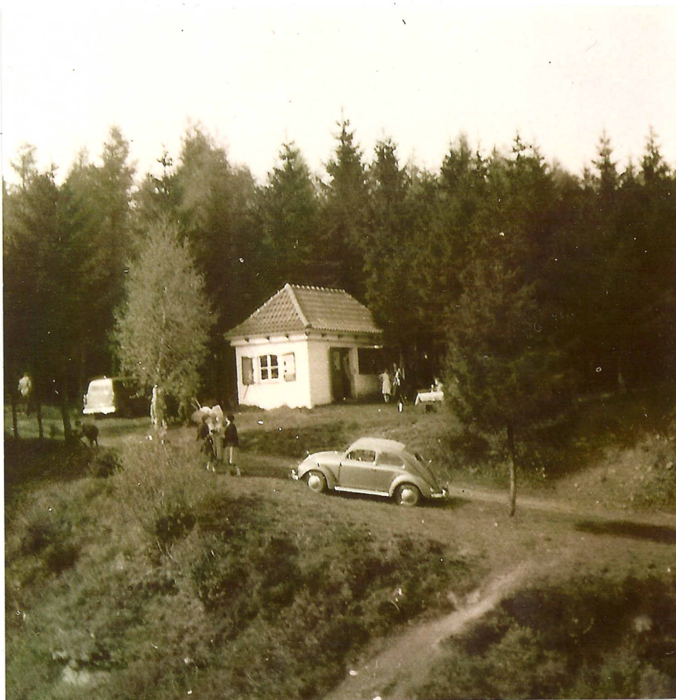
Gastronomiegebäude auf „Krögers Rott“ in den fünfziger Jahren
