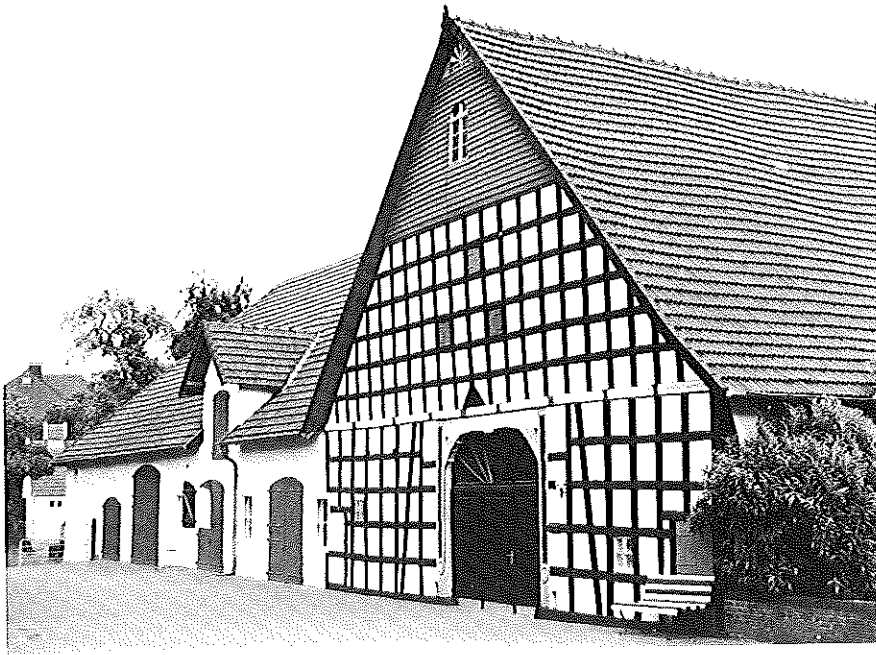
Wirtschaftsgebäude des Hofes Schütte, Mindener Straße 11, heute.
