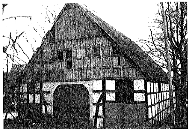
Scheune vom Hof Obermeier, gebaut 1823, heute Dorf- straße 11.
